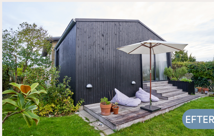
Tilbygning i forlængelse af husets gavl
